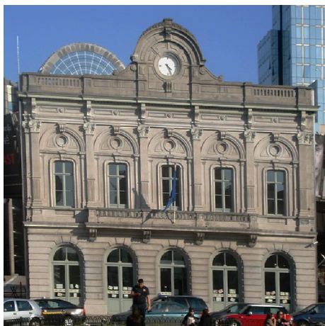
La vieille gare, dont seule la façade a été préservée.
