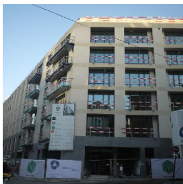
Les appartements : cela avance bien.
