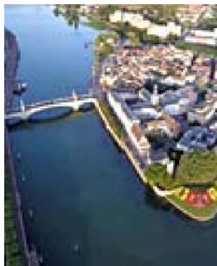
Chalon vue aérienne
